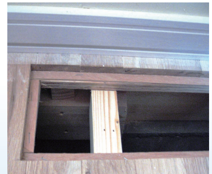
開口部施工写真
